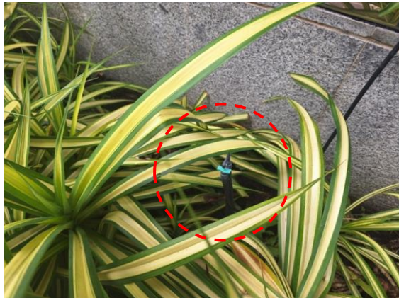
รูปที่ 2-18 ท่อรดน้ำแบบซึมลงดิน
