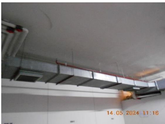
รูปที่ 2-8 ระบบบำบัดอากาศ (ท่อ Vent Pipe)
