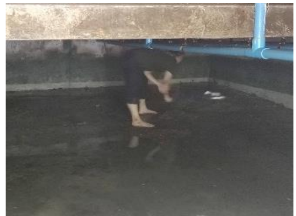
รูปที่ 2-24 การล้างถังสำรองน้ำใต้ดิน
