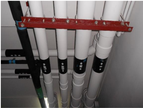
รูปที่ 2-26 ระบบระบายน้ำในโครงการแบบแยกท่อ
